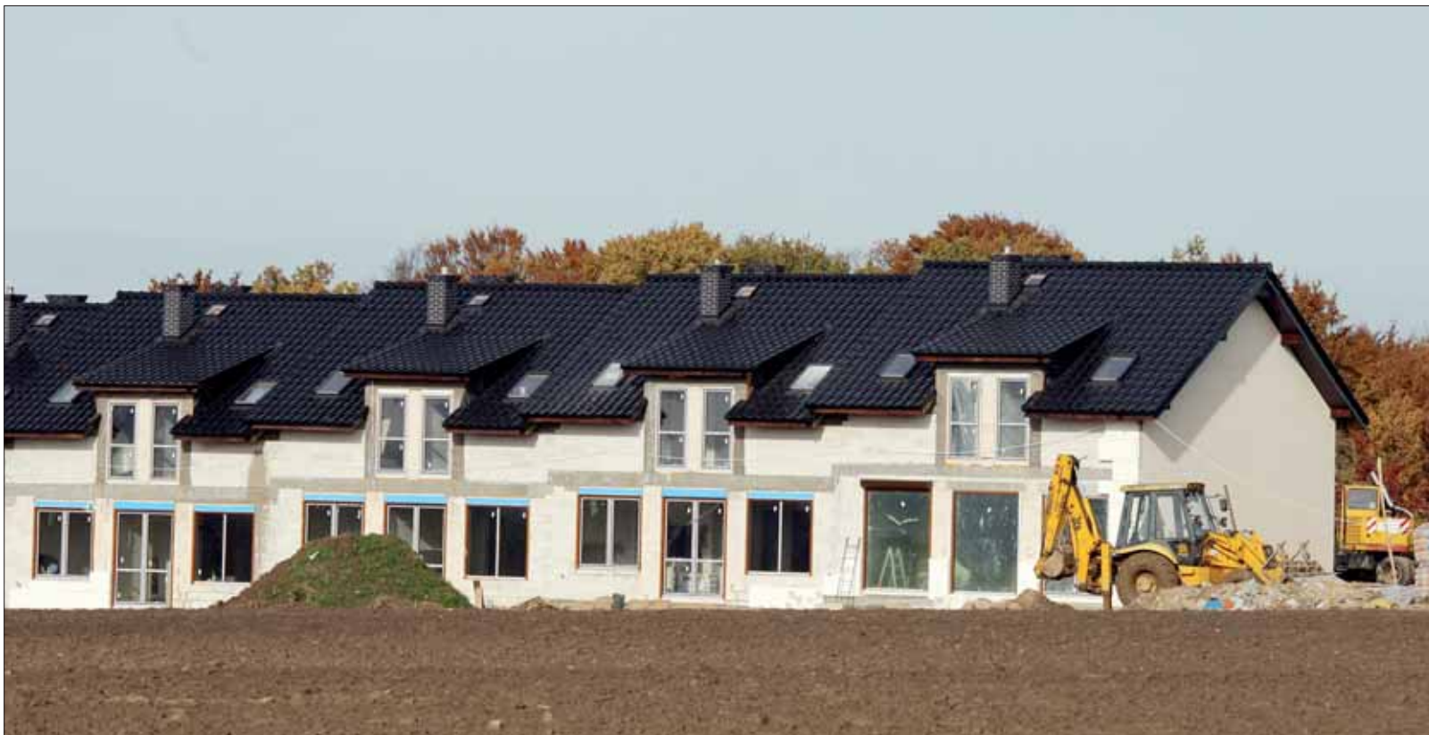
W ciągu kilku lat pod Słupskiem wyrosły nowe osiedla mieszkaniowe. Na zdjęciu: budowa szeregowców w Siemianicach.
